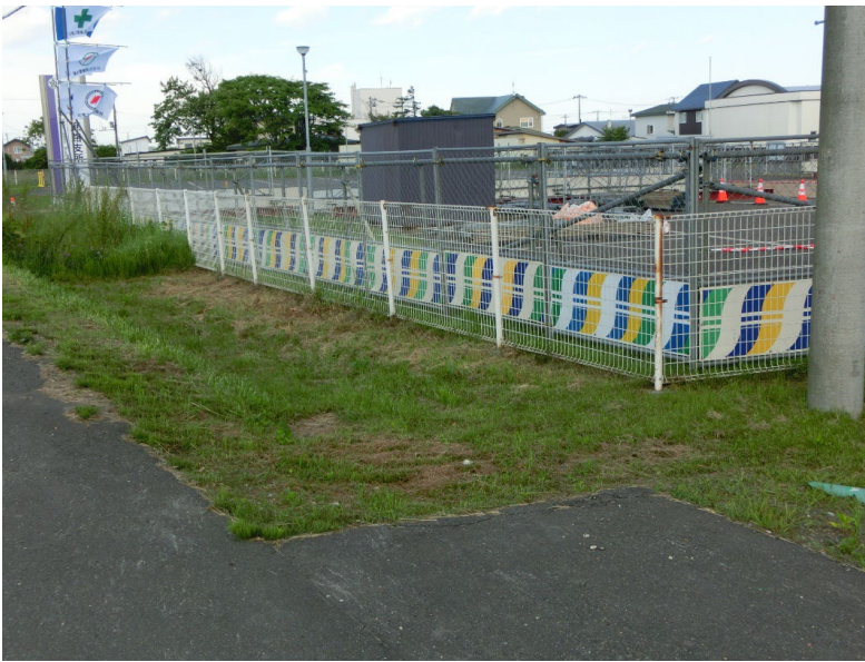
仮囲い設置完了
