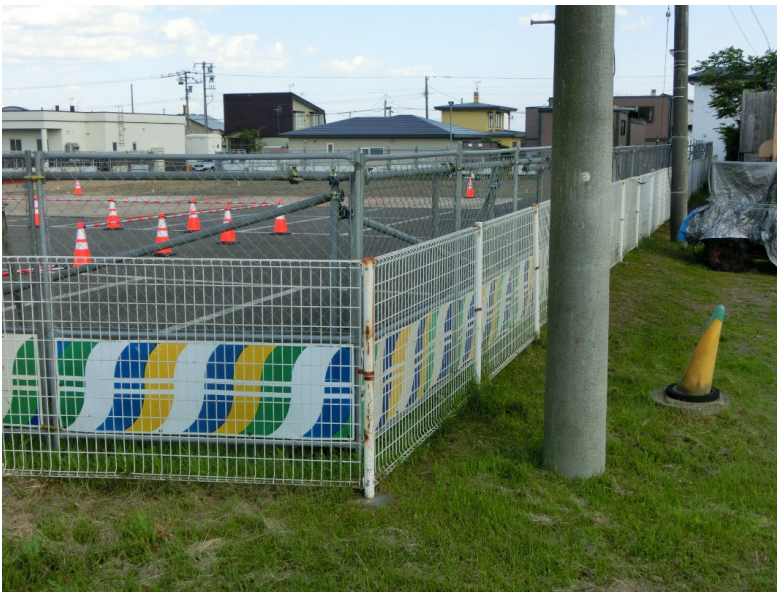
仮囲い設置完了
