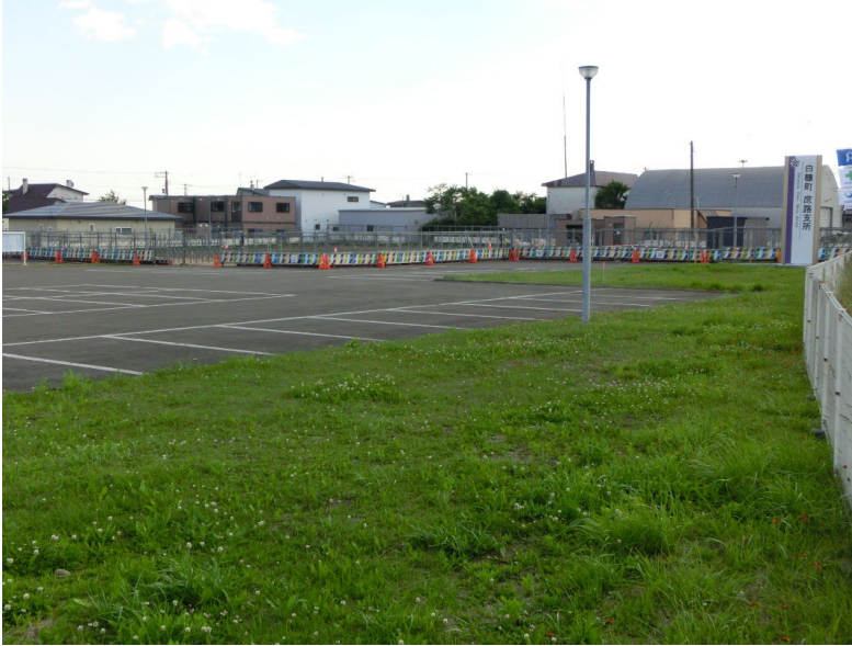
仮囲い設置完了
