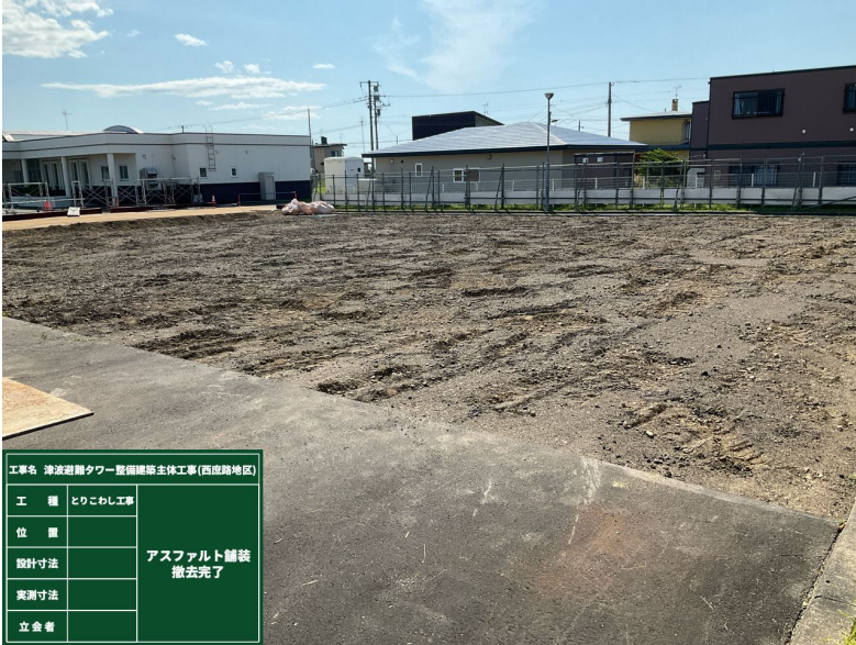
既設舗装撤去完了
